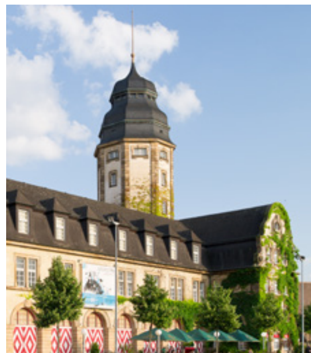
ALTE FEUERWACHE, MANNHEIM
